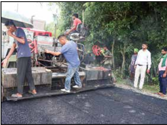
निर्माणाधिन ३८ कि.मि. कालोपत्रे सडक
