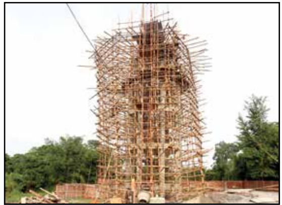
निर्माणाधिन पानीटंकी, रंगेली-२
