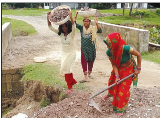
वडा नं. ५ को सडक मर्मत कार्य
