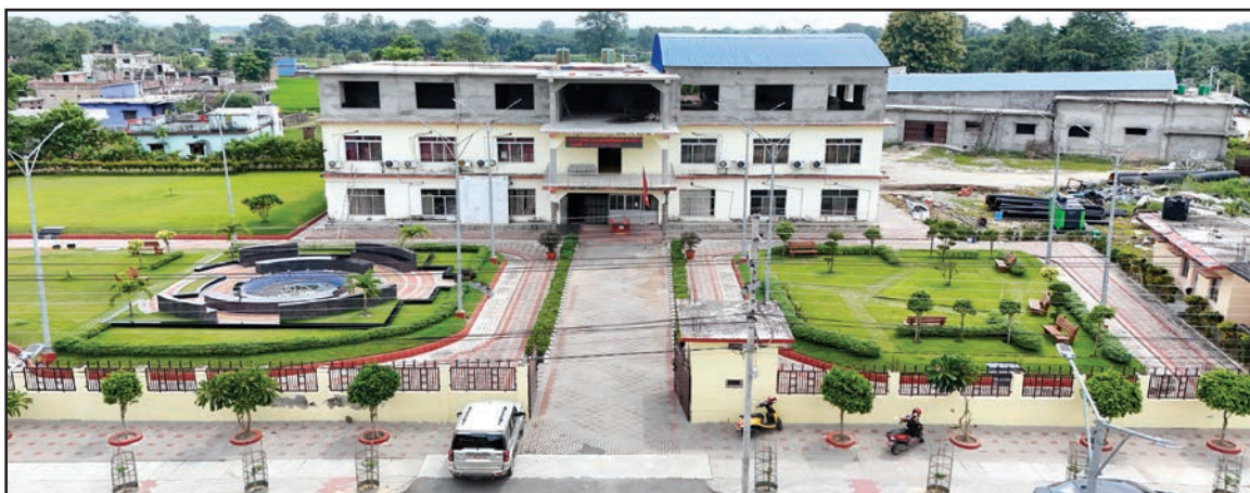
रंगेली न.पा. कार्यालयको निर्माणाधिन तेस्रो तला
