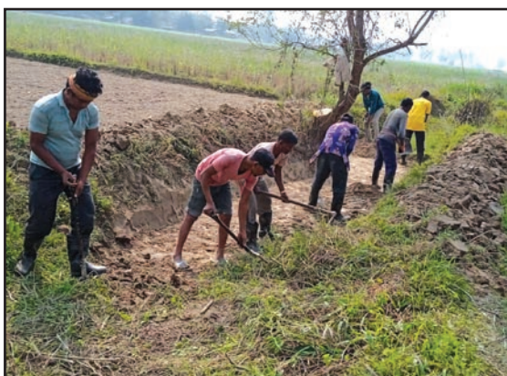
वडा नं. ५ पैनी निर्माण कार्य
